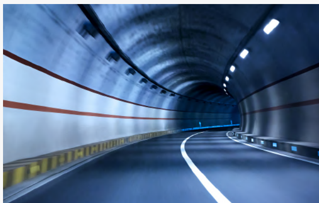
< 北京至昆明高速公路 >
