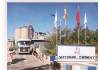
国家水泥厂房 年产能（百万吨）：1.3 全面投产日期：2022年11月
