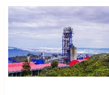
莱米水泥厂房 年产能（百万吨）：5.0 全面投产日期：2024年9月
